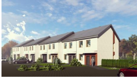
Osielsko, ul. Długa, zadanie inwestycyjne nr 1
